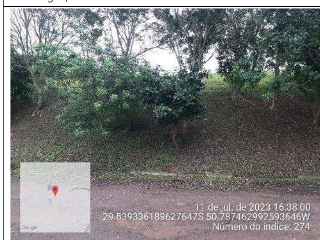
Fotografia 10-9 – Vista da célula do Aterro Encerrado
