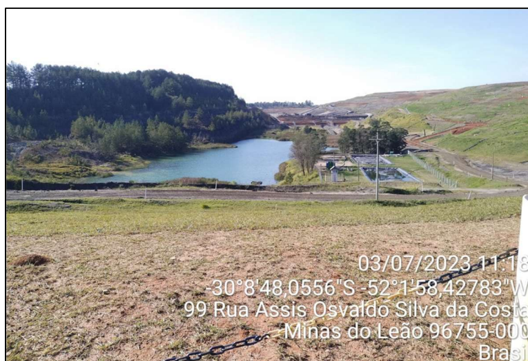
Fotografia 10-42 - Registro fotográfico da unidade CRVR Minas do Leão - RS
